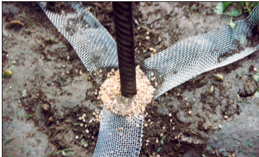
Fig. 6. Ame, chemisage et sable installés
